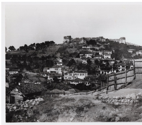
Сл.15. Тврдината (Калето) во Охрид, поглед оддалеку, напред – дрвена ограда со трска, Охрид. АИФ инв. бр.7279.
